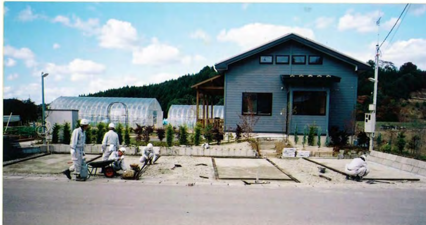
「路盤作業状況」
