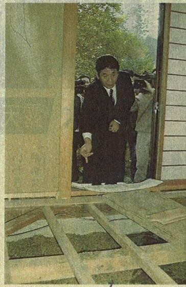
補修工事中の住宅を視察する寺田知事。千葉県山武町、みどり台団地
