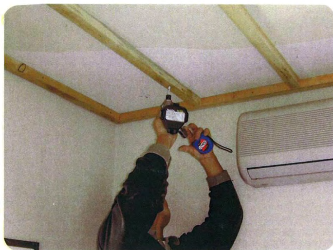
「ラピパネル取付け」
