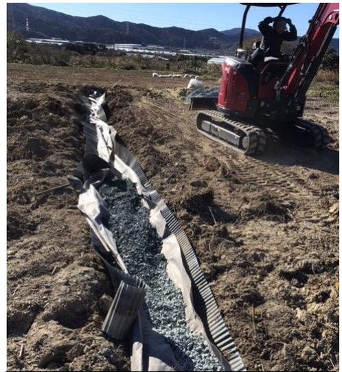
捨てられていた波板も利用して排水不良の農地に暗渠排水を施工する。長年放棄された水田基盤は岩盤並みに固く、借りた0.1㎡ハックリにはオーバーワーク気味。この農地はとりあえず玉ねぎ畑に利用して、緑肥改良の予定。
