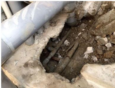
S56年築造の親族の家を本社事務所に利用。旧給湯ボイラーの取替工事で発見された上水道の複合水漏れの修理工事。複雑な配管と長年の累計漏水量を思い、嘆く。
