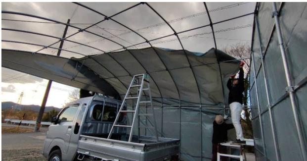
中古トラクターもH氏の手配で入手。保管に必要な車庫はパイプ主体のB5.5m×L5.7m×H3.0mの大きめなサイズにした。比較的頑丈な構造であるが、渥美半島の台風時はどうなるか。3人で苦勞して掛けたシートが飛ぶことはないだろう。
